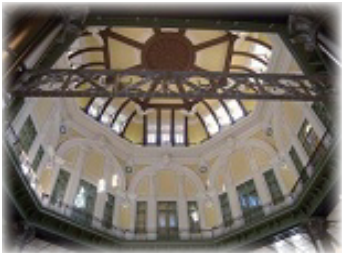
新東京駅は2階建から元の3階建に再現された丸の内・北南口共に大きな天井ドームが復元された
