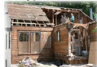
100年前の住宅の増改築現場(東シアトル)
