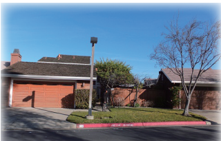
内覧した奥田邸のファサード 外壁はシダー材
