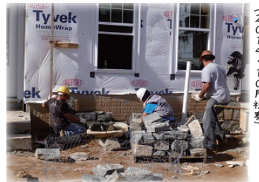
米国の建設労働者(石工)の視察先
