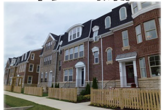
屋根裏を有効活用できるマンサード・ルーフ
