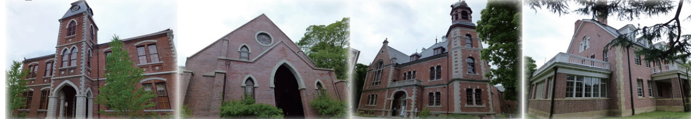
彰栄館：同志社で最古のレンガ建築(明治17) 礼拝堂：プロテスタントの教会煉瓦建築(明治19) 75-7記念館：75-7夫妻寄付(明治26) 7-モスト館：ウォリス設計のゲストハウス(昭和7)
