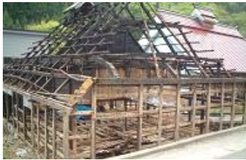
会津『田島』の庄屋の解体 古材は手壊しで 2004年
