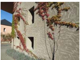
元修道院をリノベーション
