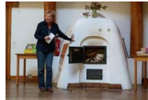
かまどの様な漆喰塗りのストーブ ストーブの燃料は木質なら何でもOK
