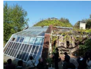
太陽熱集熱のパッシブソーラーパネル +太陽光発電のアクティブソーラーパネル
