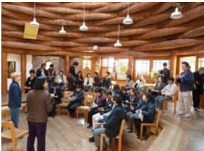
木材は黒い森のドイツトウヒ(松科)丸太を八角錐状に組み上げたもの
