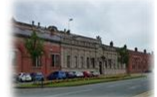
今なお残るユニバー社屋と工場
