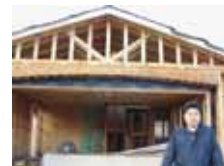
ガレージ改築中(カーソン地区)
