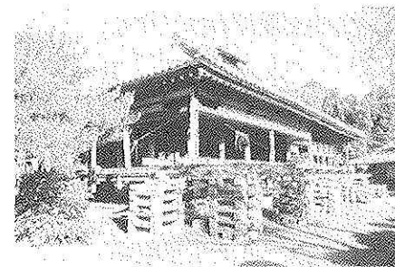
揚げ屋 南西面
