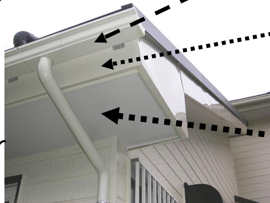
築20年：破風ラワン板、雨樋塩ビ製、 軒天井4mmベニヤ(野木町)
