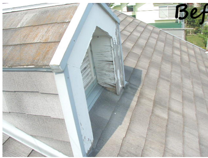
築15年：コロニアル屋根(野木町)
