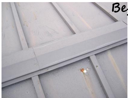
築25年：トタン屋根(下野市)
