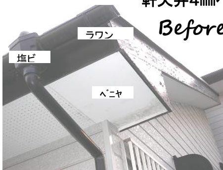
築20年：破風ラワン板、雨樋塩ビ製、 軒天井4mmベニヤ(野木町)
