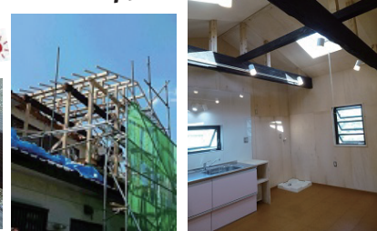
古材を再活用した増改築 完成しました (小山市)
