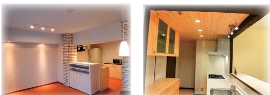
「自然素材」を多用したマンション改修 施工例: 自治医大ミラパセオ・タイパレス
