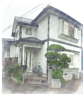
野木町 (12月施工)
