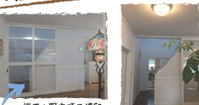
施工：野木町F様邸 OPENにした状態 階段 使わない夏は脇までスライド
